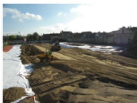
Travaux de recouvrement des terres après excavation – Pose d'un grillage avertisseur et d'un géocomposite bentonitique (membrane utilisée comme agent d'imperméabilisation. C'est la bentonite qu'elle contient, gonflant au contact de l'eau, qui la rend parfaitement étanche)
